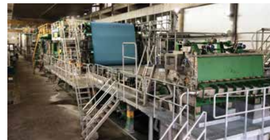
Prenovljeni mokri del KS2 med obratovanjem Renovated wet end of the KS2 cardboard machine during operation
